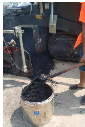
1) 干法 SBS 在拌合楼人工投放 2) 拌合楼取料试验 3) 摊铺机位置取料试验
