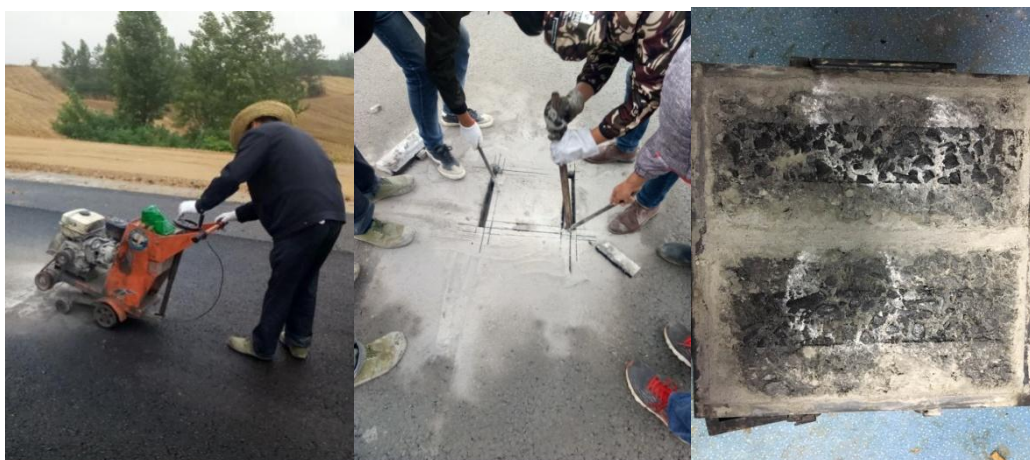
在铺筑完成的路面上现场切割试件进行性能测试
